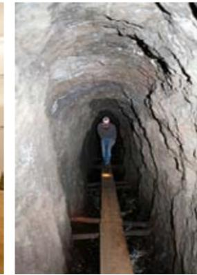
Das Wasserkraftwerk Grüner Hirsch befindet sich im Harz tief unter der Erde. Gut 140 Meter Falltiefe hat das Wasser, wenn es durch dieses Kraftwerk rauscht und über die angeschlossenen Generatoren „grünen“ Strom produziert. Anschließend fließt es im Stollen gemächlich dahin und tritt viele Kilometer weiter aus dem Boden ans Tageslicht.
