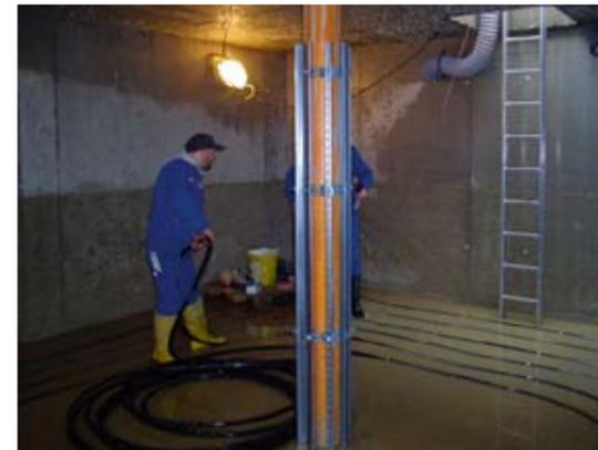
Längst ist der Solar-Eis-Speicher von einer dicken Erdschicht bedeckt und quasi unsichtbar. Aufnahmen vom Rohbau zeigen da schon mehr. Links unten gut zu sehen: die Wärmetauscher. Sie verlaufen inzwischen in parallelen Schlangenlinien in mehreren horizontalen Ebenen. Unten rechts: Mareike Lehnhardt, ESB-Pressesprecherin, und Manfred Maier, ESB-Projektverantwortlicher, freuen sich über den hohen Nutzungsgrad der Anlage.
