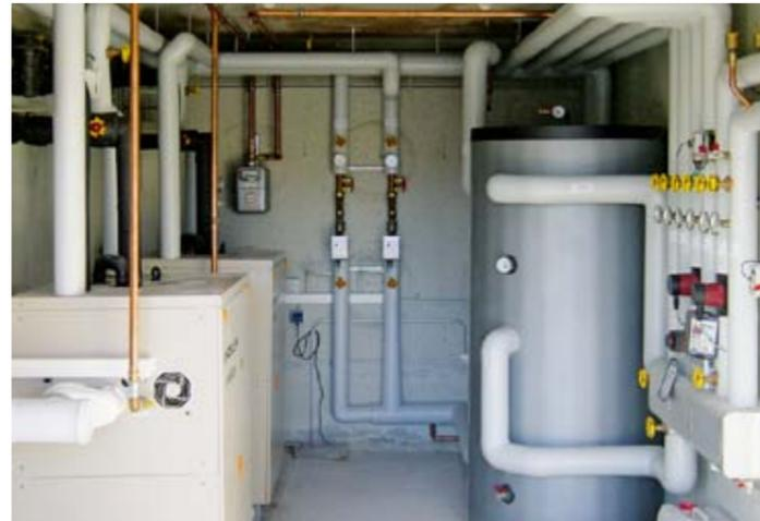
Technikraum zum Solar-Eis-Speicher, damit die Wärme bzw. Kälte entsprechend der Jahreszeit im ESB-Betriebsgebäude ankommt.
